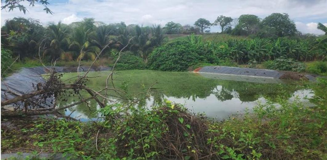
*Figura 4. Albarrada impermeabilizada, foto tomada en cantón Rocafuerte. Fecha: 03-02-2023.*
