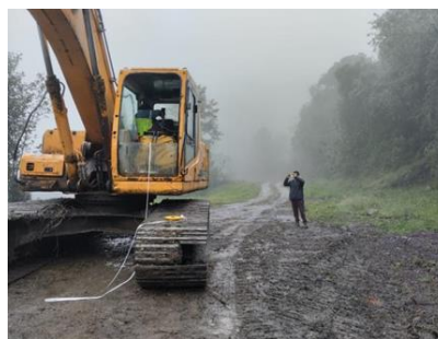
Figura 9: Prueba de visión en excavadora
