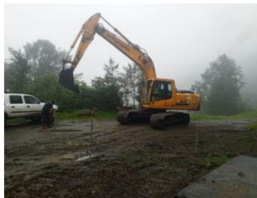
Figura 8: Prueba de puntos ciegos en excavadora
