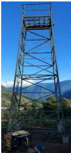
Fig 61. Estructura metálica de la torre
