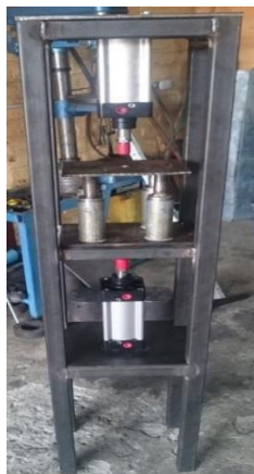
Figura 11. Aplicación de soldadura a la estructura
