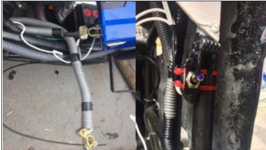
Figura 8. Instalación del interruptor
