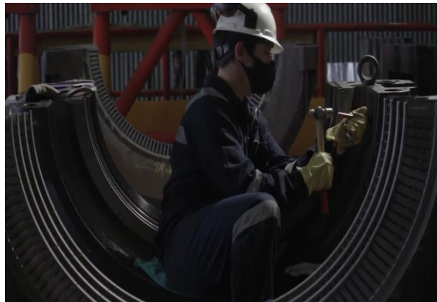
Figura 2. Desmontaje de turbina de vapor 65MW.
