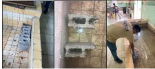
Figura 9: Colocación de bloques en piscina
