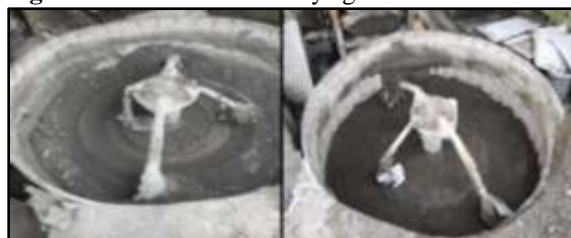
Figura 6: Colocación arena y agua en la mezcladora
