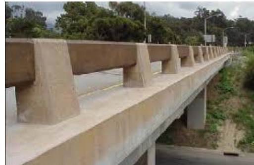
b) Poste y barandales de hormigón armado
