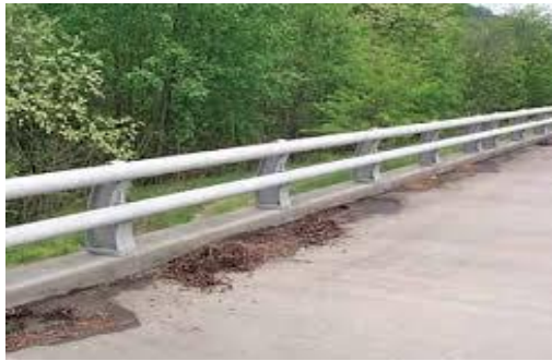
a) Poste y barandales de acero estructural
