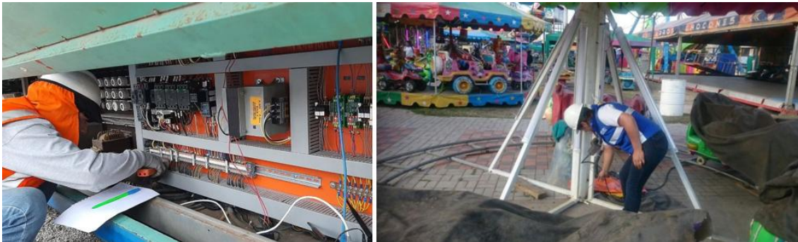
Ilustración 4. Inspección de corrosión en componentes de en juegos mecánicos.
