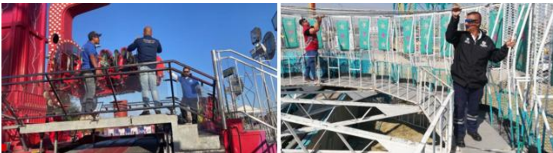
Ilustración 2. Instalación y revisión en juegos mecánicos.
